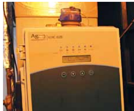
Figur 4. Styringsenhed på Agam affugter hos Gartneriet 4kløver, indstillet til et sætpunkt på 75%. Til venstre ses isoleret varmerør, gennem hvilket der tilføres varmt vand til regenereringen.
