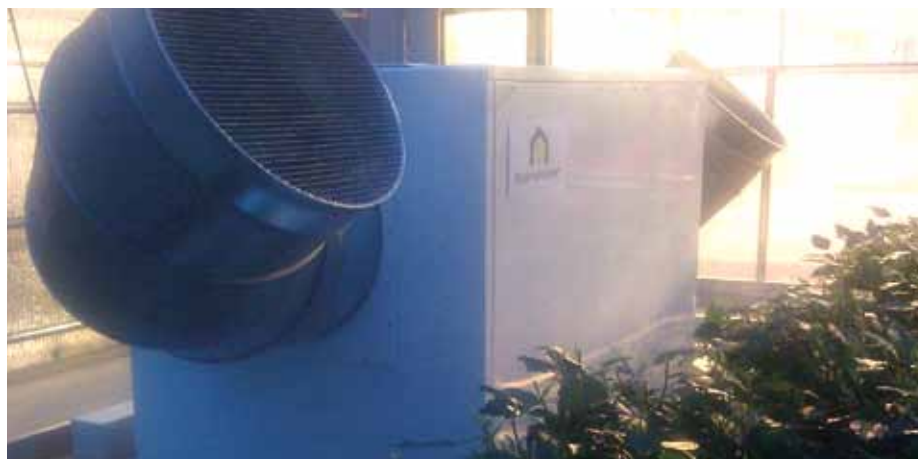
Figur 3. Denne Dantherm køleflade affugter er opstillet på Kold College på et mobilbord, hvormed affugteren er mobil.
